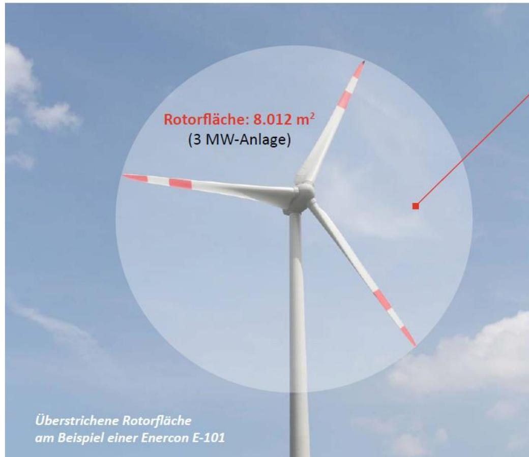
■ **3 m<sup>2</sup>** Rotorfläche einer Windenergieanlage decken den jährlichen Strombedarf einer vierköpfigen Familie.
