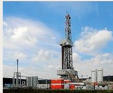
Ein Erdgasförderturm wie hier in Niedersachsen könnte bald auch in Nordwalde stehen.
